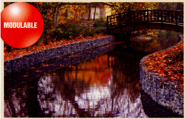
Gabions constitués d'une cage monobloc en fils acier électrosoudés revêtus d'un alliage zinc/aluminium et remplie in situ ou en carrière de pierres non gélives, non friables et de dimension homogène. Mailles carrées ou rectangulaires recoupables permettant des configurations en biseau, arrondies, en escalier, etc. Arêtes rectilignes résistant à la déformation pour un usage adapté aux travaux de soutènement, aménagements paysagers, murs antibruit ou clôtures.
