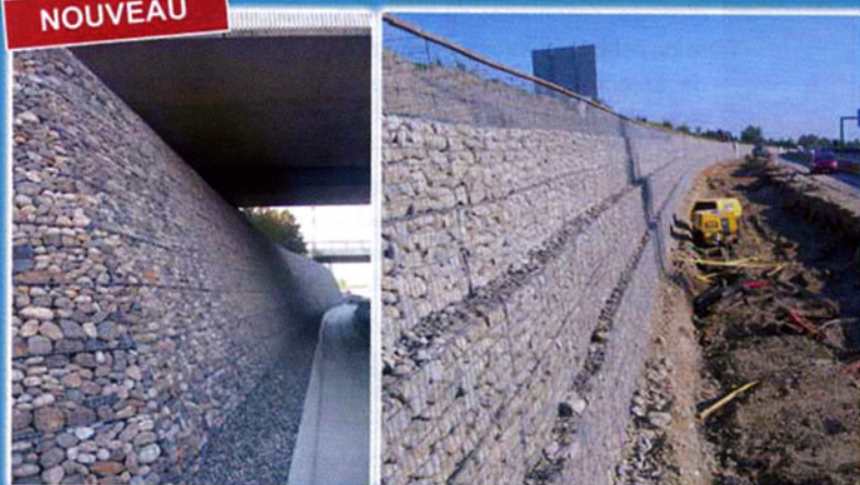
Rocade Est de Toulouse, 2 kms de gabions. Groupement Guintoli et Malet
