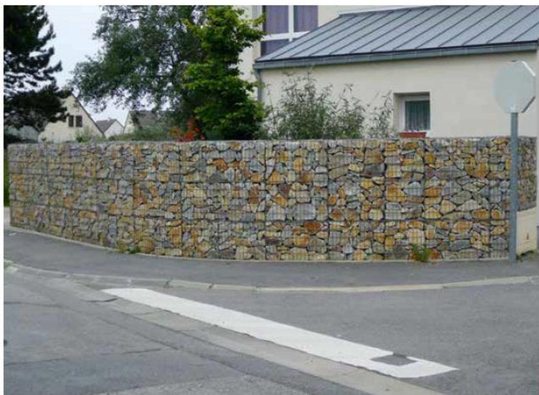
Parmi les produits phares de l'entreprise, les gabions électrosoudés (cf. photo) et les géonattes d'hélophytes, lancés en France grâce à AquaTerra Solutions®.
